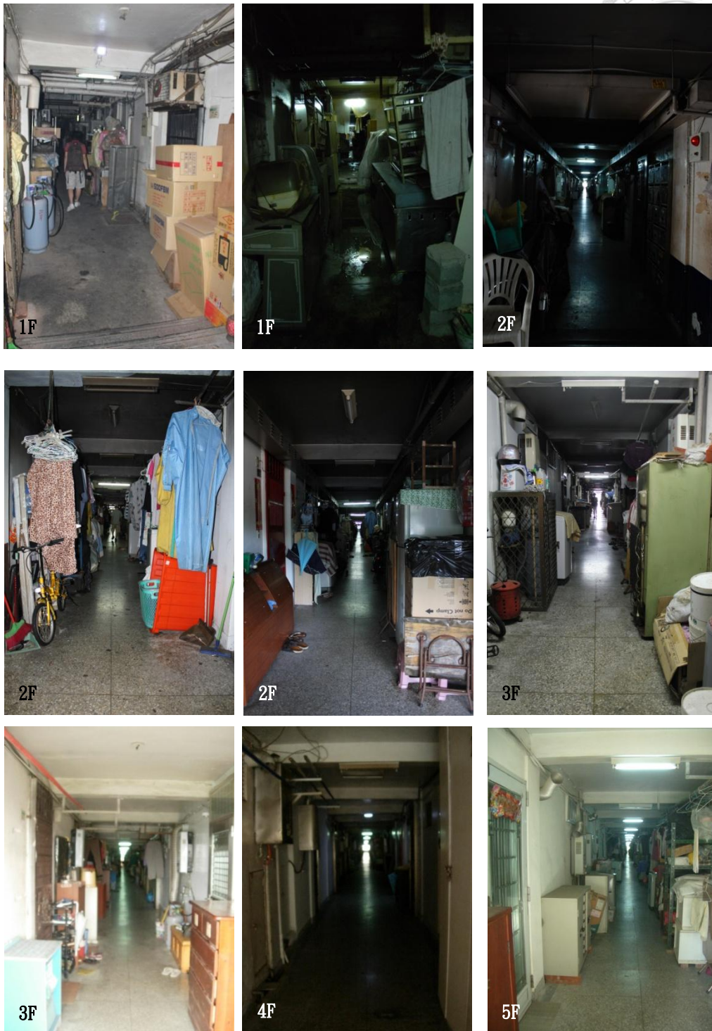
圖 5-1 劍潭一期 B 棟各樓層之中央走廊使用方式
