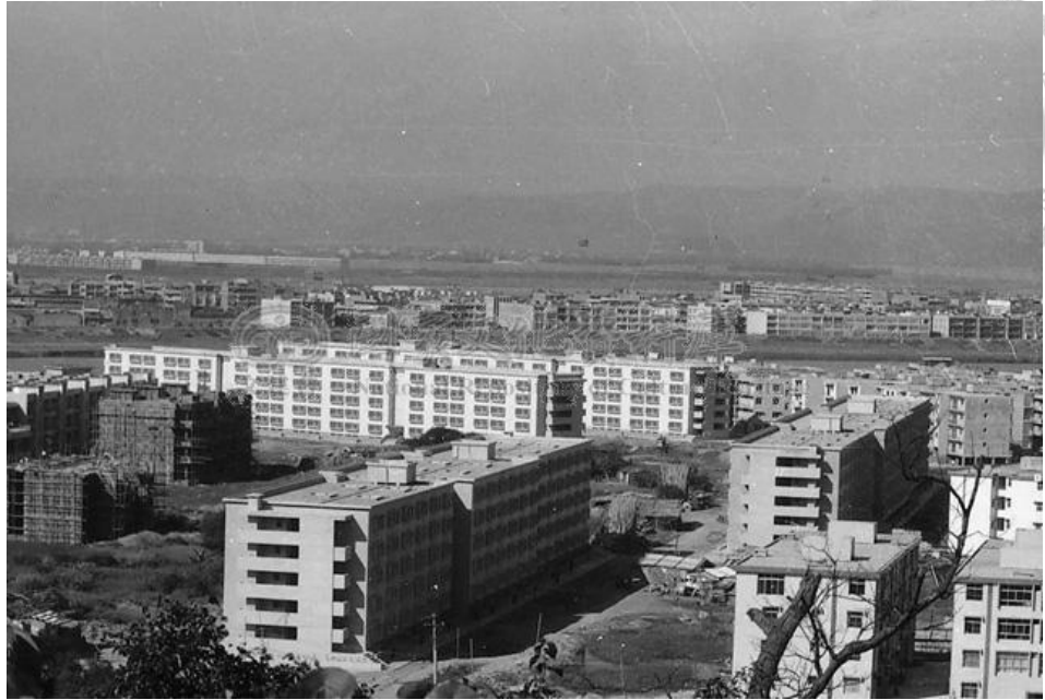
圖 4-4 劍潭一期整宅 984 戶竣工照
